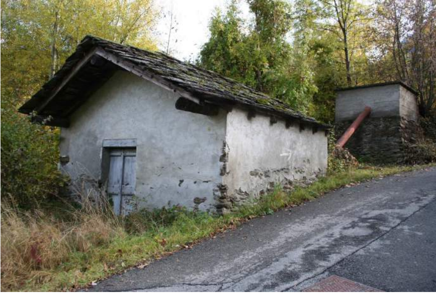
Vue du moulin de Plantey, avec le réservoir et la canalisation construits en 1963.
